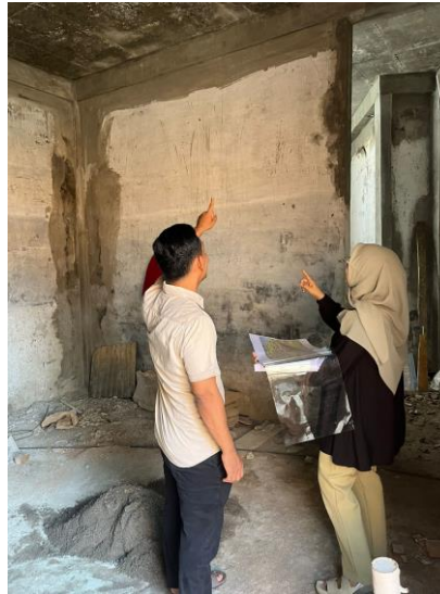
Gambar 10. Pendampingan teknis pada tahap pelaksanaan konstruksi
