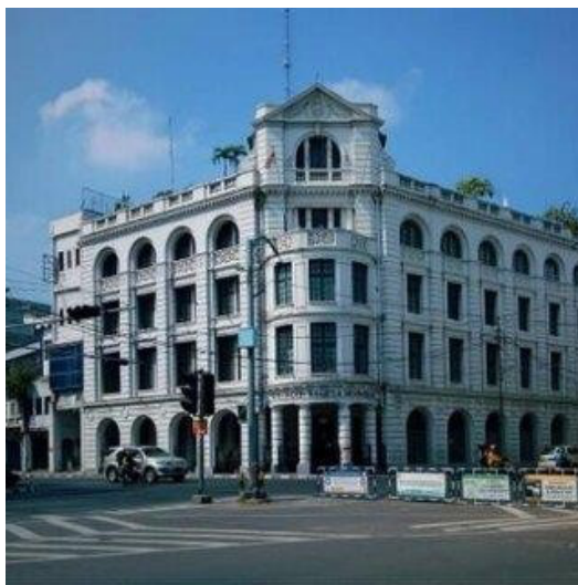
Gambar 2. Gedung London Sumatra Berdiri Tahun 1906 dan Sebagai Kantor Perkebunan Harrison & Crossf
