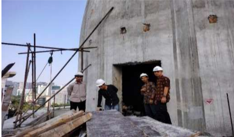
Gambar 7. Dokumentasi Survey Lapangan pada Menara 99
