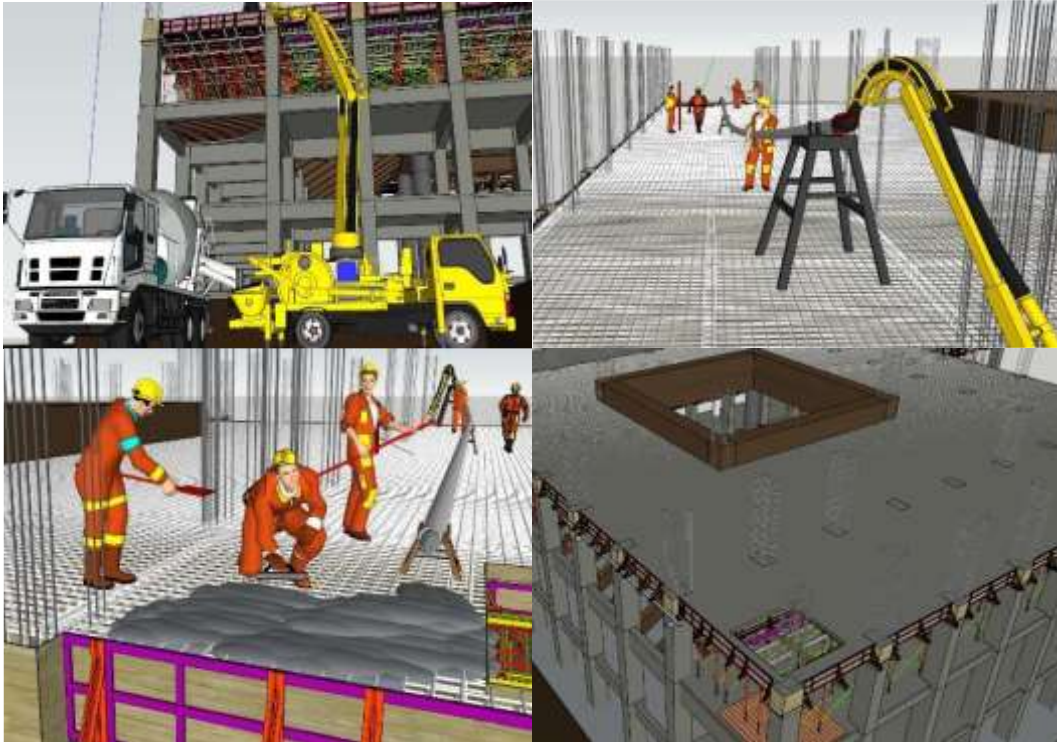
Gambar 19. Dokumentasi Pengerjaan Pengecoran Plat dan Balok Lantai 2 Aula pada Sketchup
