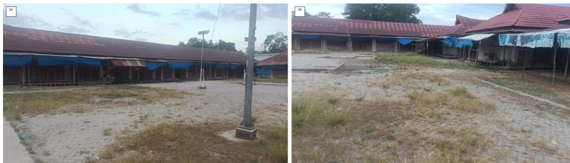
Gambar 4. Kondisi kios/los dan koridor internal yang menunjukkan variasi penataan komoditas
