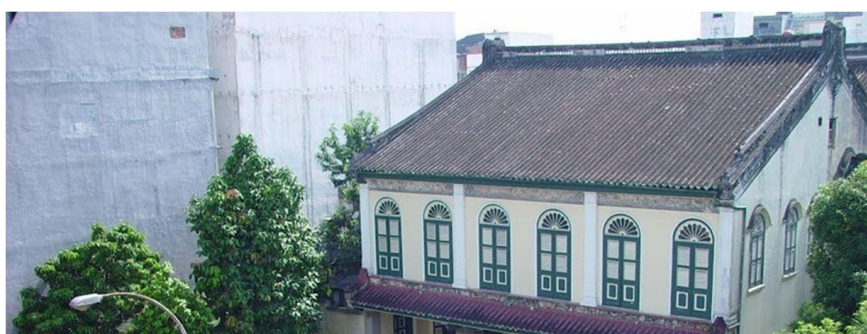
Gambar 8. Model atap bangunan Tjong A Fie Mansion dengan tingkat kemiringan lebih dari 45^\circ
