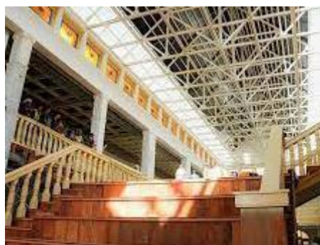
Gambar 8. Kondisi Eksisting Tangga Warenhuis
