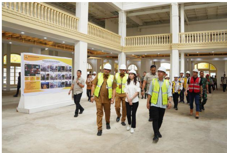
Gambar 7. Kondisi Eksisting Fasad dan Lantai 1 Warenhuis
